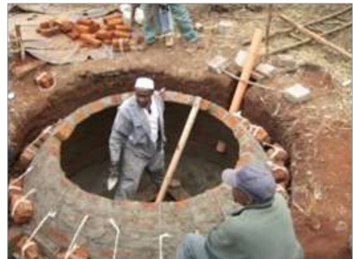
Bau von Biogasanlagen für Haushalte in Kenia
